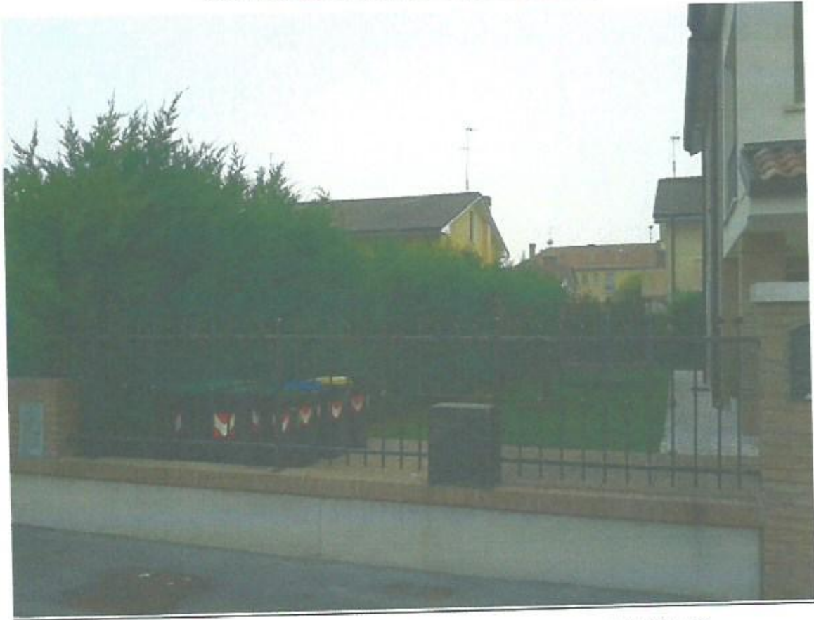
FOTO 1 – VISTA LATO EST LOTTO N. 6 GIA' EDIFICATO
