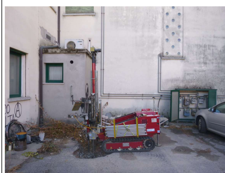
Foto 1: Esecuzione della prova CPTU1
