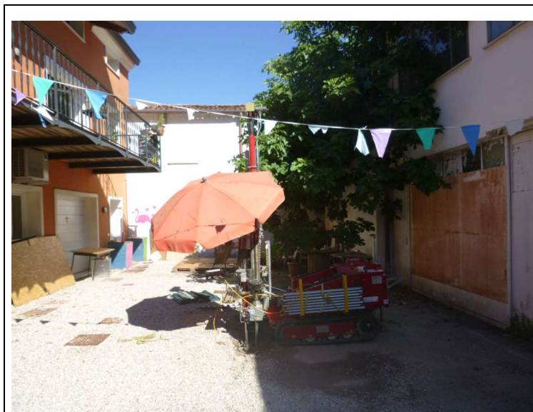
Foto 2: Esecuzione della prova CPTU2
