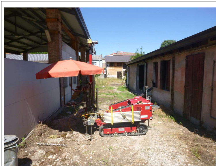
Foto 3: Esecuzione della prova CPTU3
