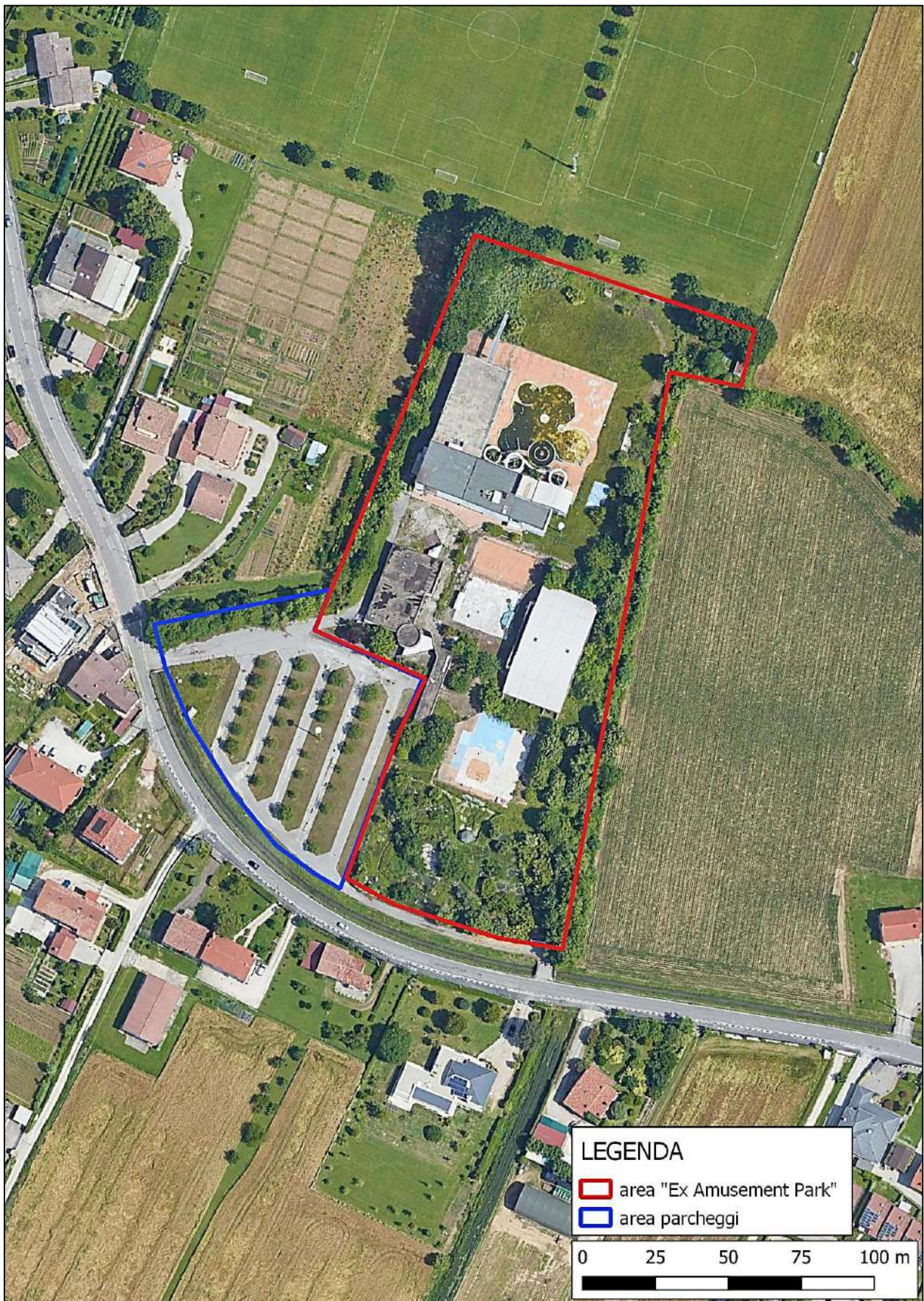
Figura 2.2– Immagine satellitare dell'area oggetto d'intervento (fonte Google Earth)
