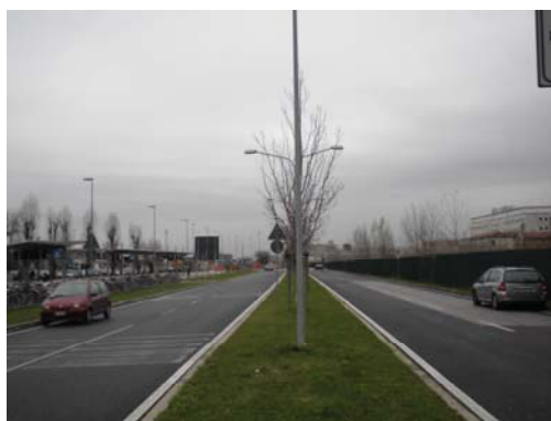
Figura 11 – Viale della Pace: vista in direzione "Ponte Verde"
