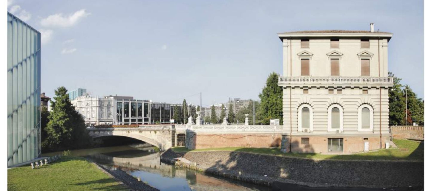
In corrispondenza delle spalle del ponte, sono visibili i due passaggi sotto l'impalcato, oggi chiusi.
