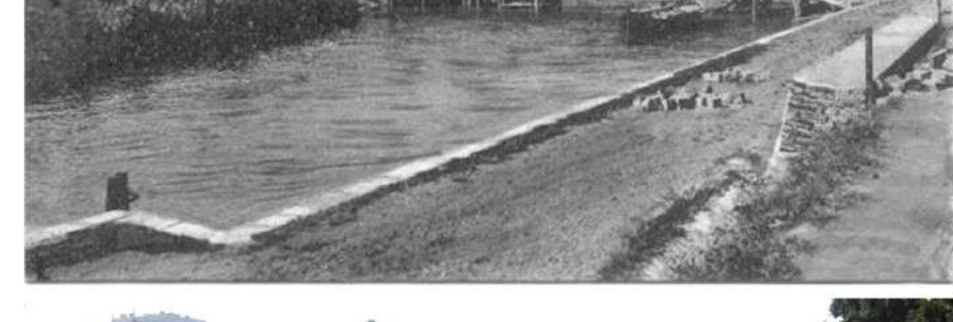
SOPRA: Carlolina dell'epoca, in primo piano la banchina di carico del carbone, a monte dell'impianto meccanico di sollevamento dell'ex gasometro. In corrispondenza delle spalle del ponte, sono visibili i due passaggi sotto l'impalcato, oggi chiusi.
