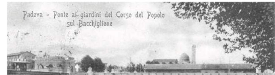
Ponte di Corso del Popolo, vista dall'area ex Gasometro, sponda sx.
