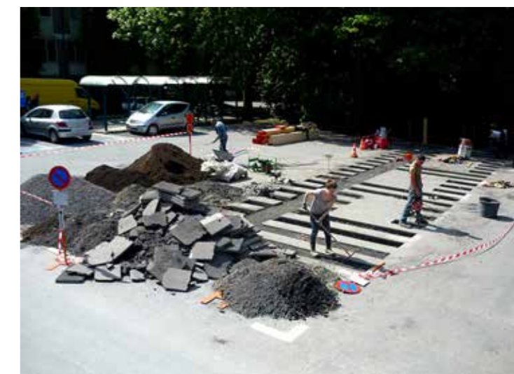
Figura 09.16. Un esempio di depaving nel progetto Boerenhol [Park]ing a Kortrijk, Belgio, dello studio Wagon Landscaping. [Fonte: http://landezine.com/index.php/2012/10/boerenhol-parking-by-wagon-landscaping/ ]
