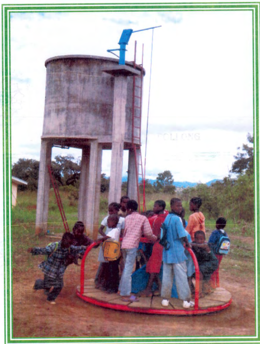
Pozzo a giostra realizzato da IFP nel 2009 nel sud del Camerun
