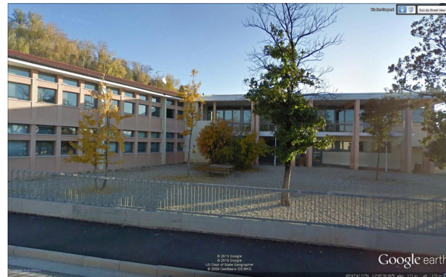
Nuovo Asilo Nido e Nuove Scuole Elementari .
