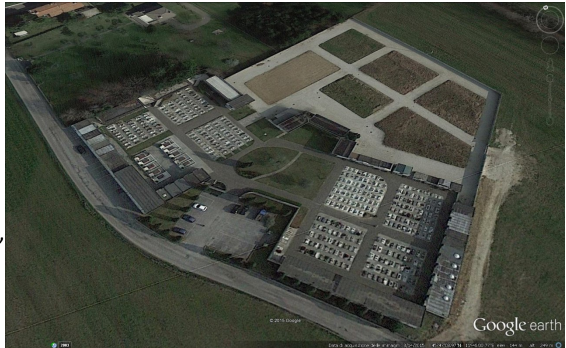
Interventi di Edilizia Cimiteriale.
