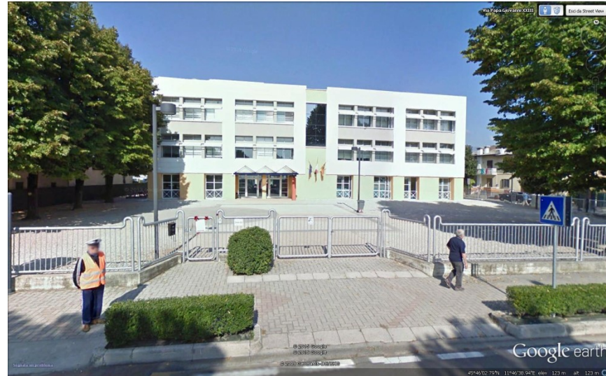
Ristrutturazione Scuole Elementari e Medie Esistenti.
