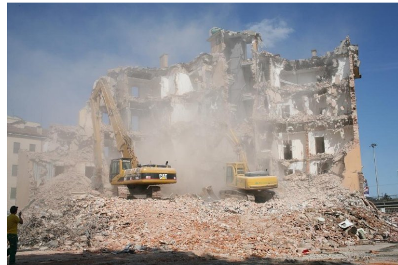
D.LL. CSE Demolizione edifici
