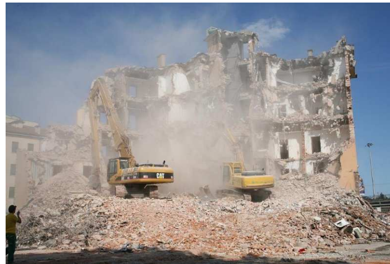
D.LL. CSE Demolizione edifici
