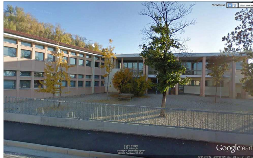
Nuovo Asilo Nido e Nuove Scuole Elementari .
