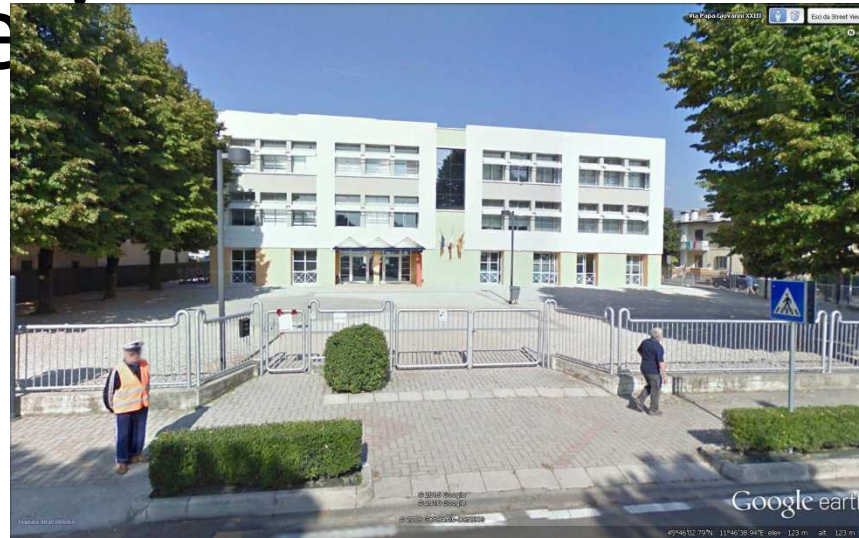
Ristrutturazione Scuole Elementari e Medie Esistenti.
