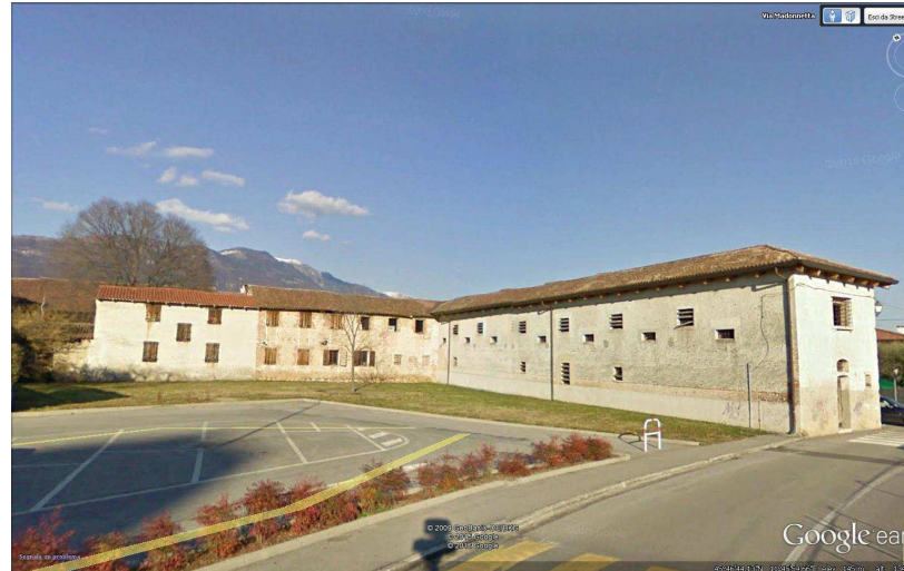
Interventi su Edifici Storici Comunali.
