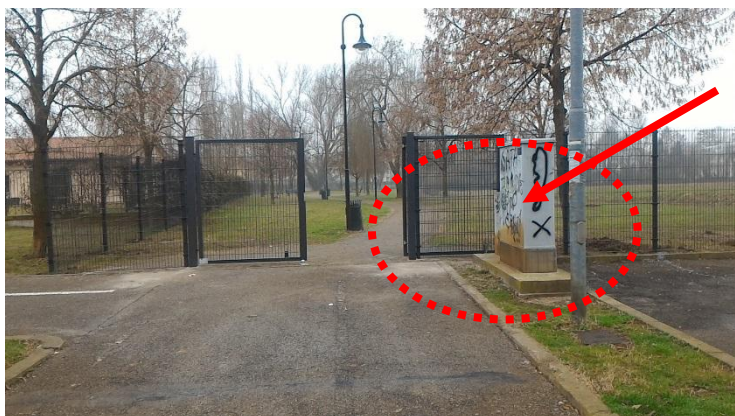
Presenza di quadro elettrico presso ingresso di Via Siena: pericolo di folgoramenti: recintare e segnalare
