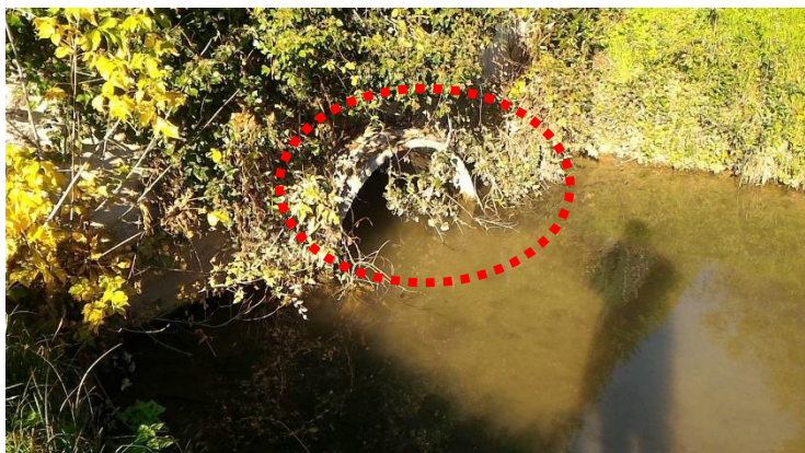
Presenza di tubazione di arrivo del canale Boschette ed inizio di questo a cielo aperto: mantenere pulito
