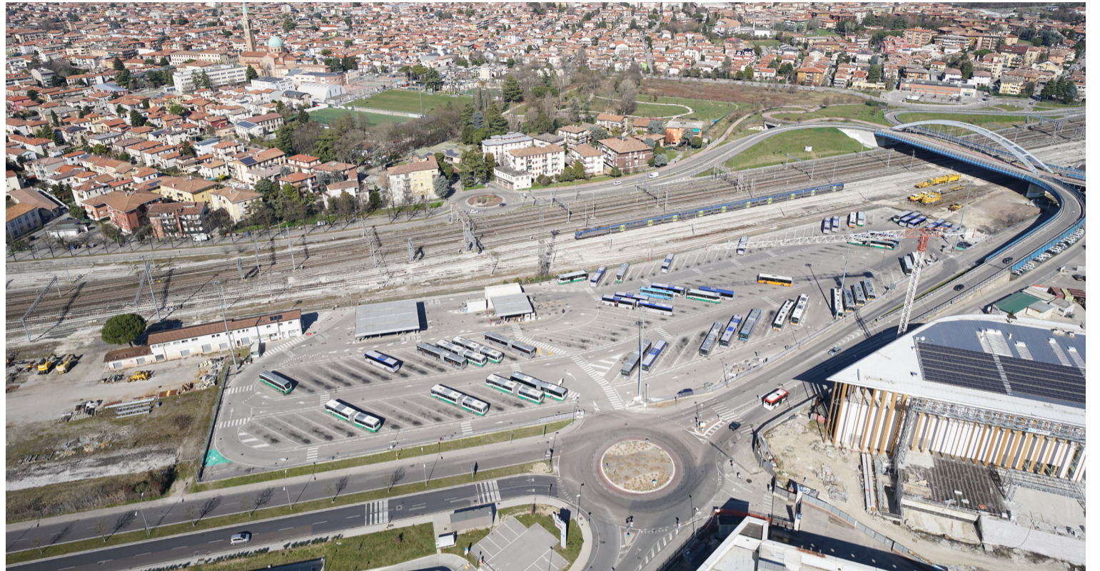
6. Vista da Sud Ovest verso deposito autobus Ponte Unità d'Italia
