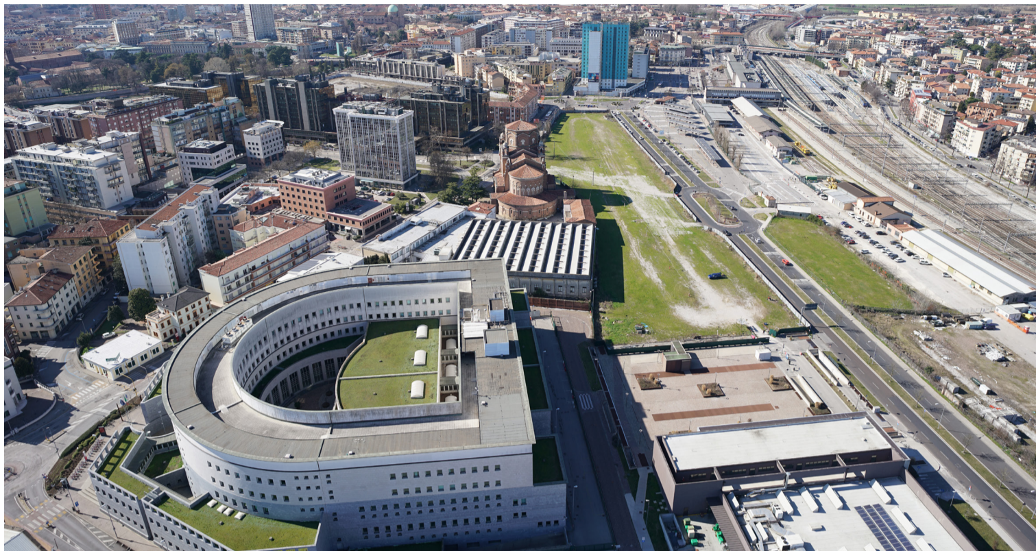
3. Vista da Est verso area IFIP e Palazzo di Giustizia
