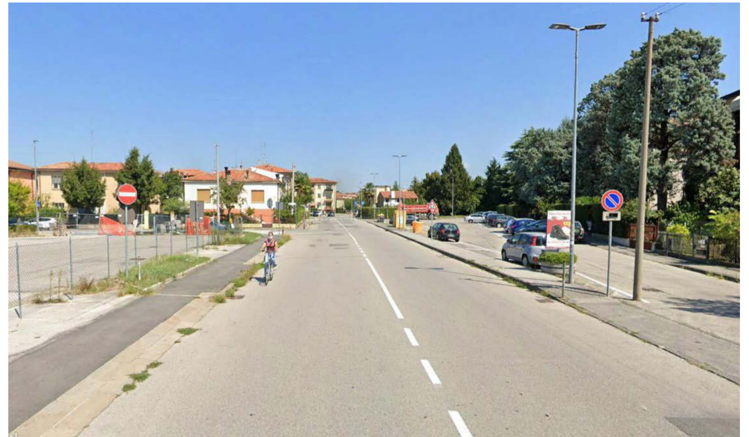
Via M. Buonarroti - Tratto 3-4
