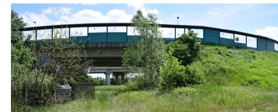
Paesaggio intercluso tra le infrastrutture
