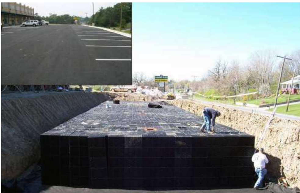
Figura 1- Cella modulare in materiale plastico in fase di montaggio
