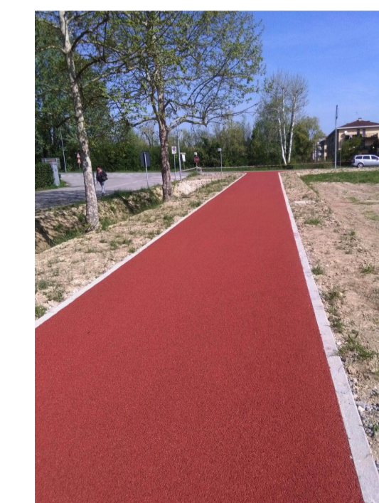
vialetto in cls drenante
