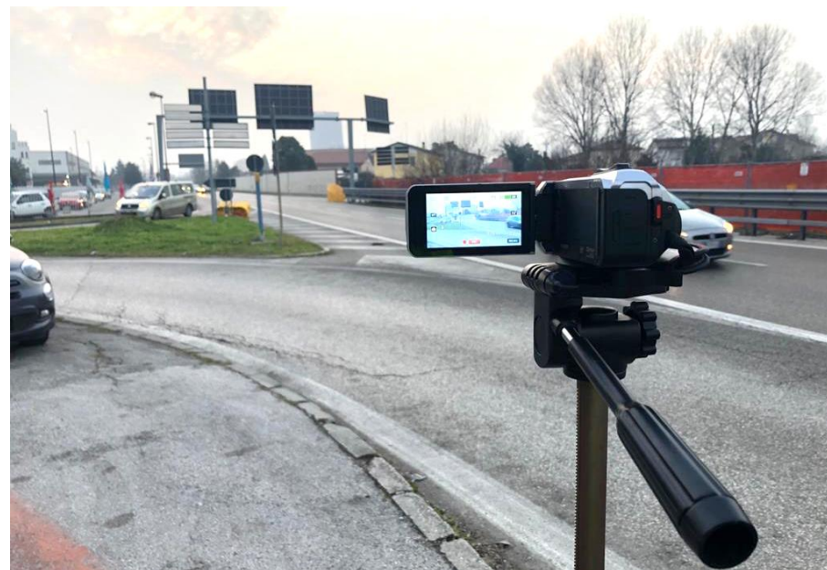
Figura 24 – Esempio telecamere installate a supporto delle indagini manuali
