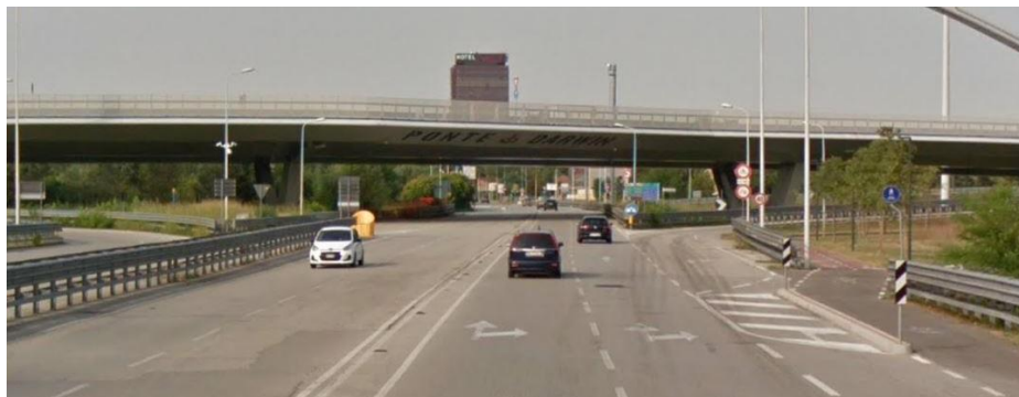
Foto 15 – S15: via San Marco (lato est della SR308) – direzione ovest
