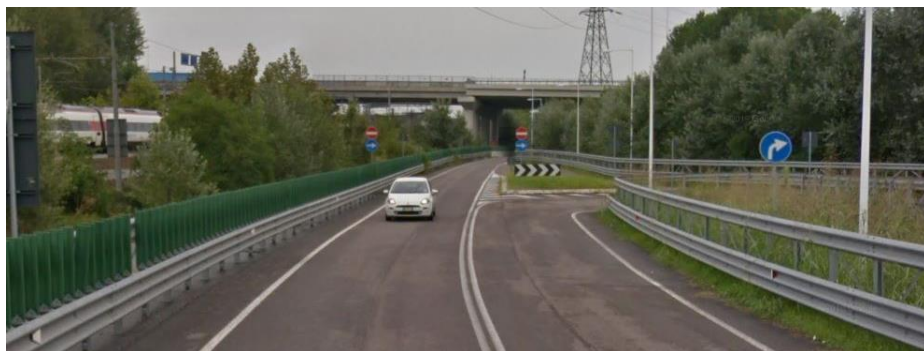
Foto 1 – S1: via Mozzoni – direzione est
