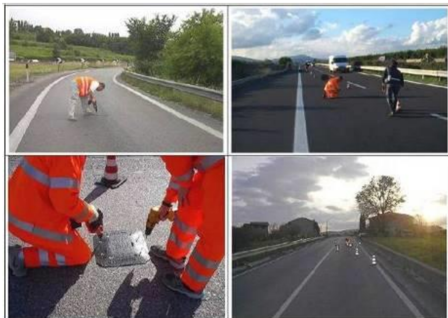
Figura 151 - Esempio installazione delle piastre
