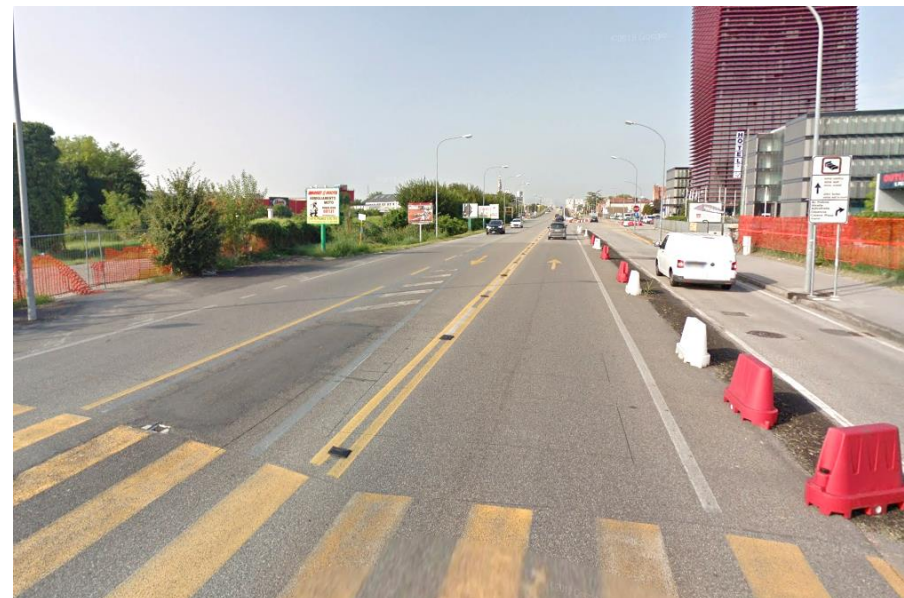
Figura 36 – Vista ramo ovest rotatoria di via San Marco
