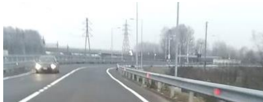
Foto 2 – S2: via Arco di Giano – direzione est
