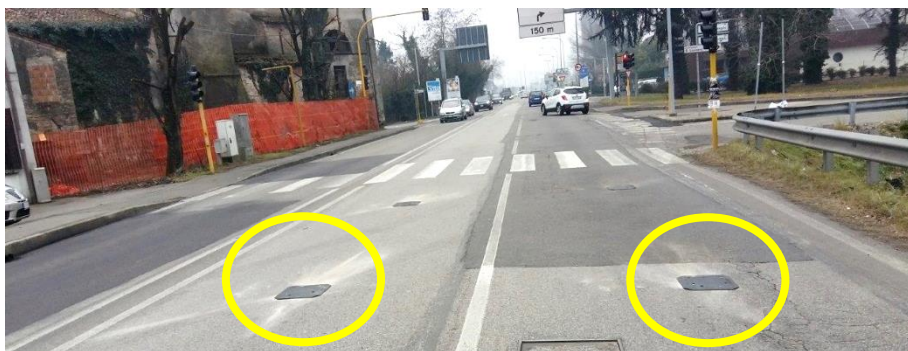
Foto 18 – Esempio installazione apparecchiature per rilievo automatico
