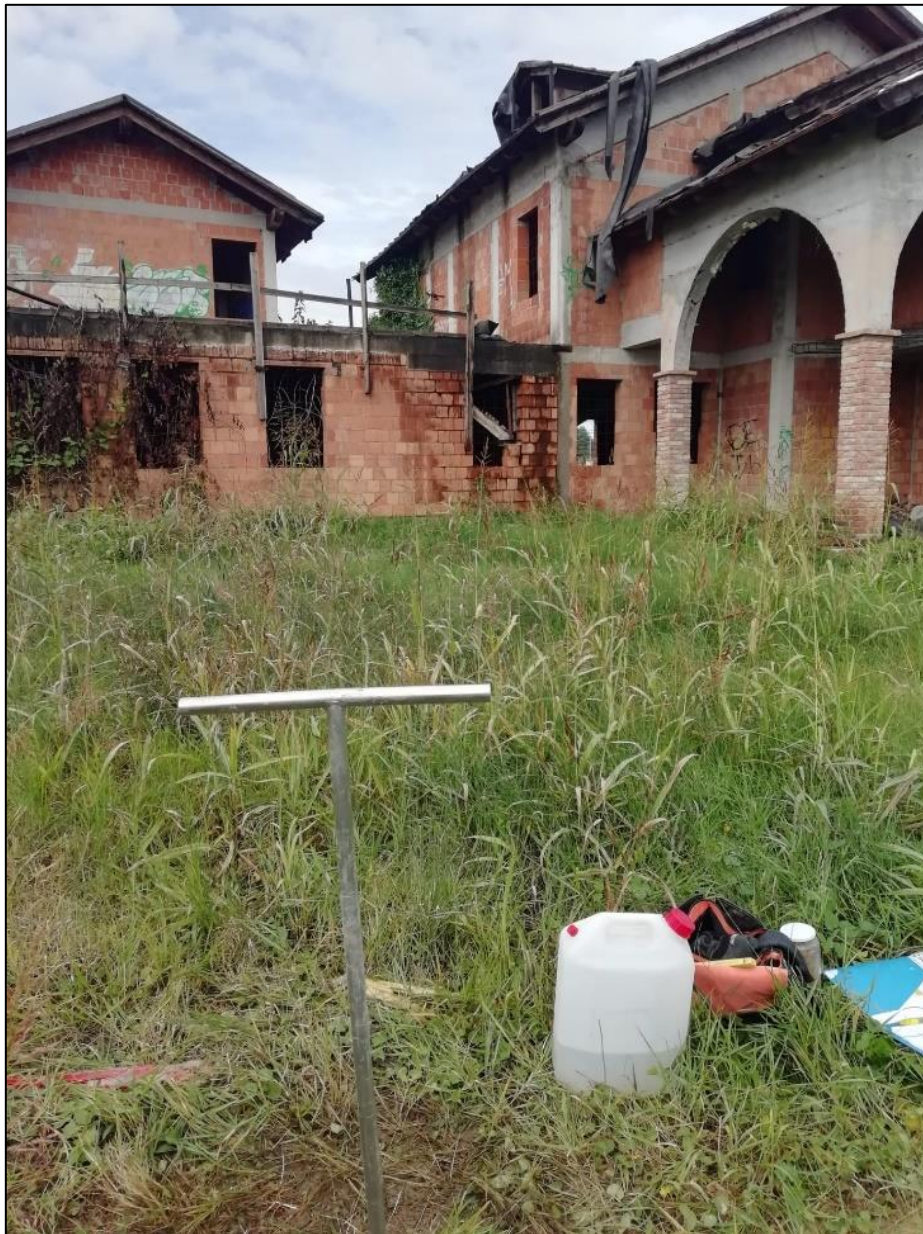
Figura 5: foto della trivella leggera durante l'esecuzione del sondaggio
