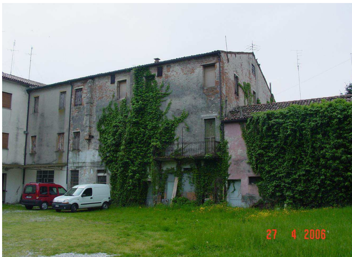
Prospetto interno nord del corpo centrale su via Campagnola
