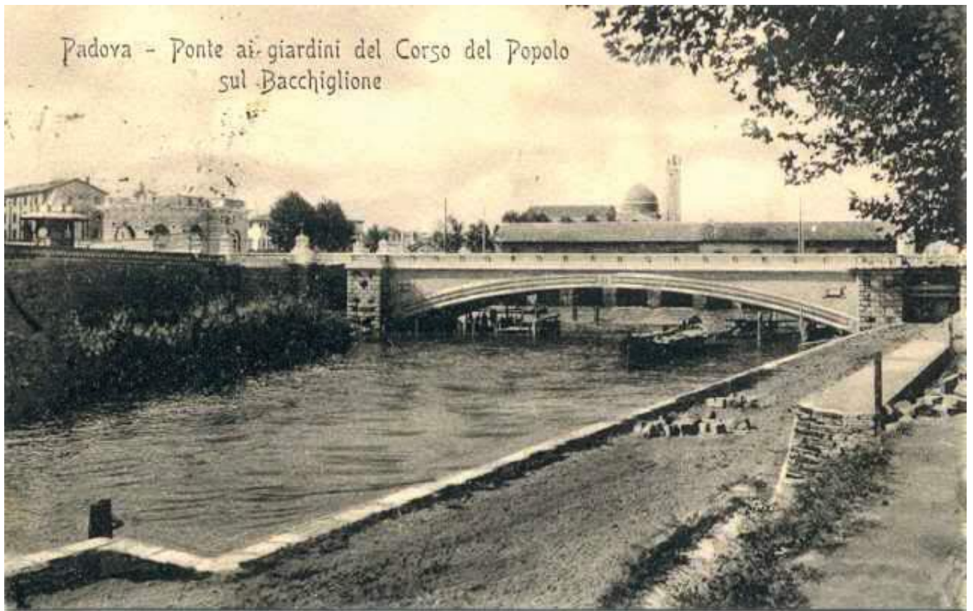
Figura 6 - La banchina del nuovo porto ai primi del Novecento. Alle spalle del ponte si intravede la Briglia del Carmine.
