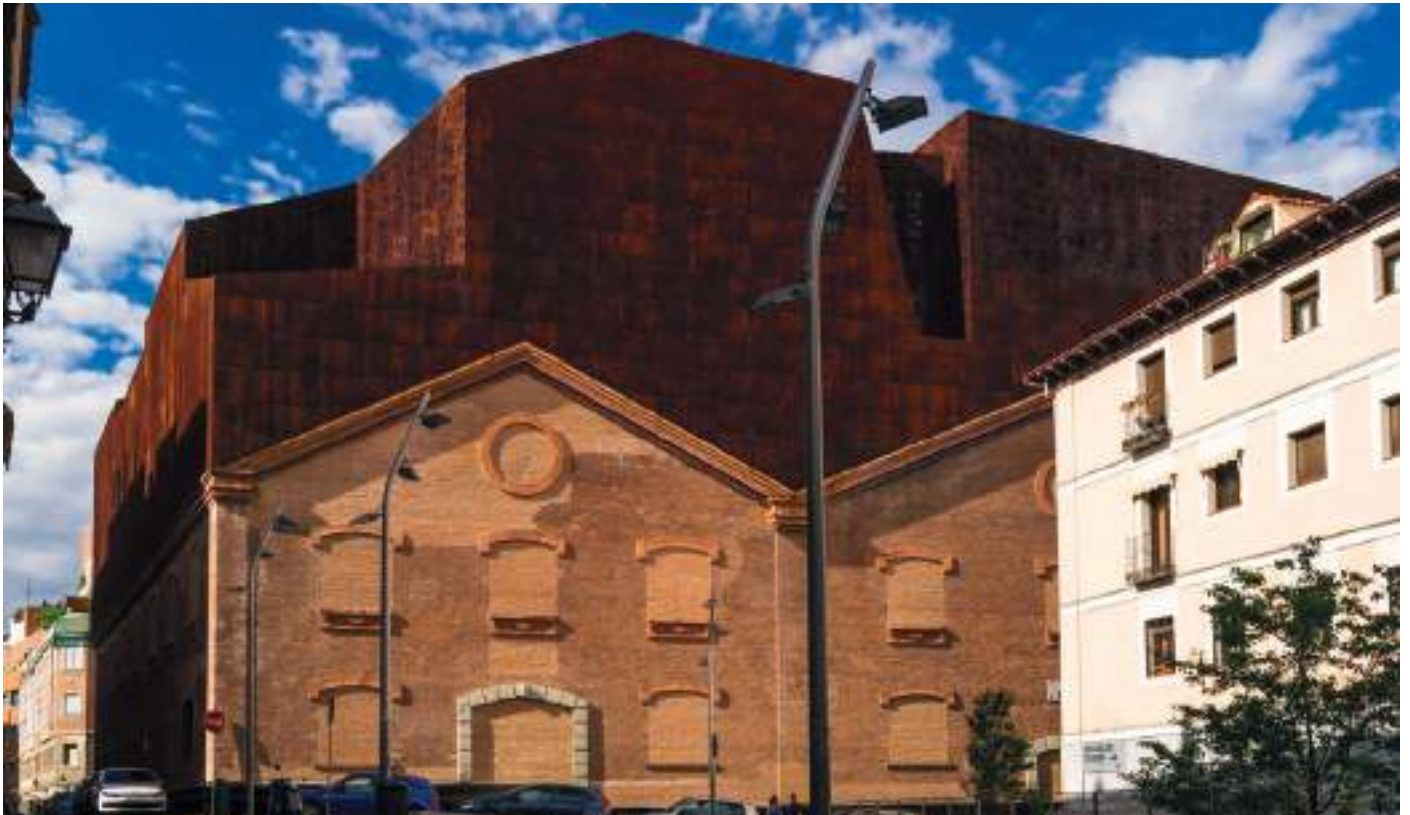
4. sopraelevazione e ampliamento di una vecchia centrale elettrica realizzato da Herzog & DeMeuron, Madrid
