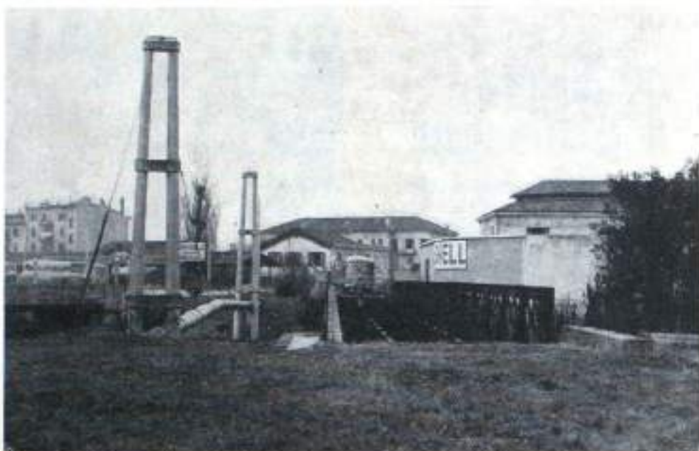
E' stata deliberata la costruzione di un nuovo ponte sul Piovego, fra via Mergagni e via Gozzi: il manufatto, in cemento armato, sorgerà sul posto di questo ponte in ferro della Veneta (foto Lux).
