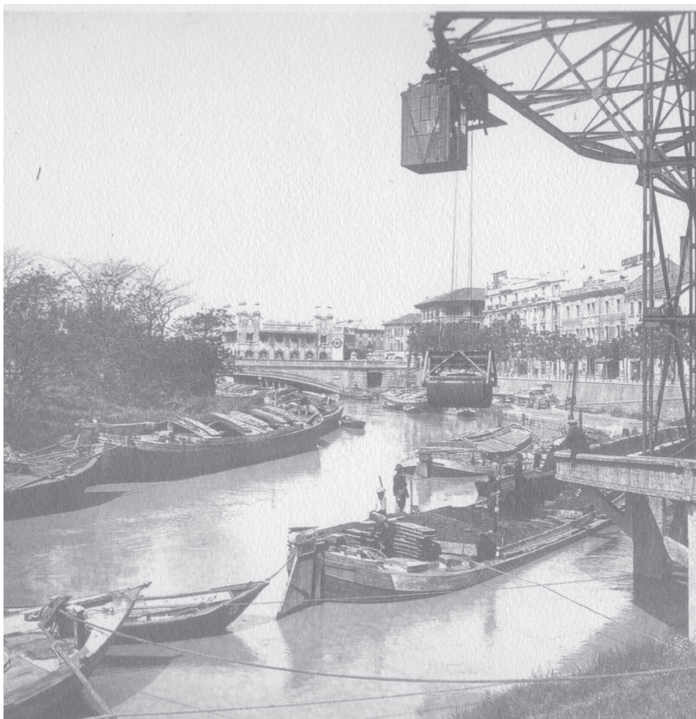
Figura 7.1 - La gru di sollevamento del carbone in attività si intravede nel fondo la gru a braccio del nuovo porto.
