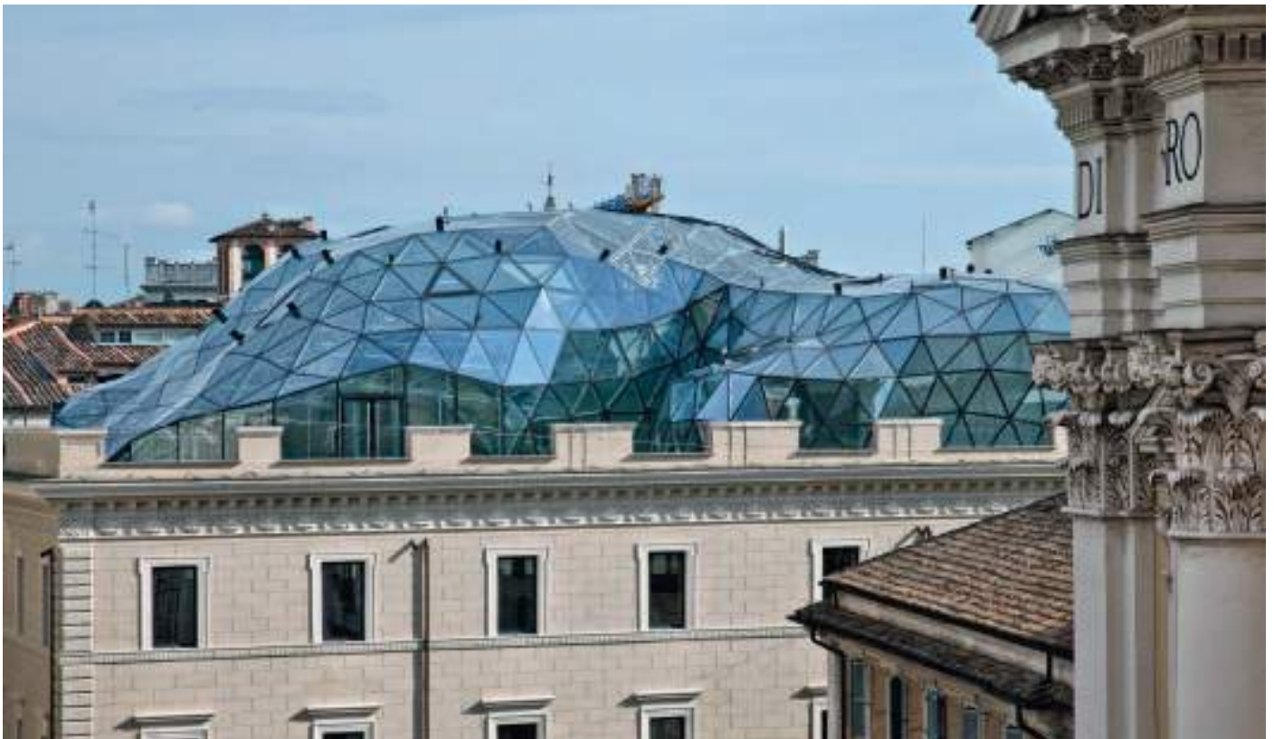
8. sopraelevazione La Lanterna, Roma, M. Fuksas
