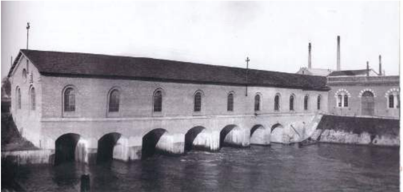
Figura 8 - La Briglia del Carmine vista da valle. Alla destra l'ala della motrice a vapore di emergenza.
