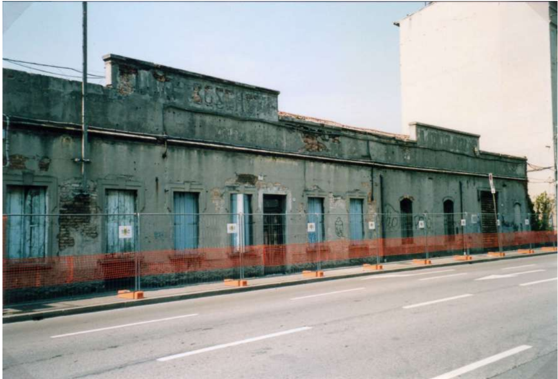
Magazzini Bortoluzzi, demoliti negli anni '00
