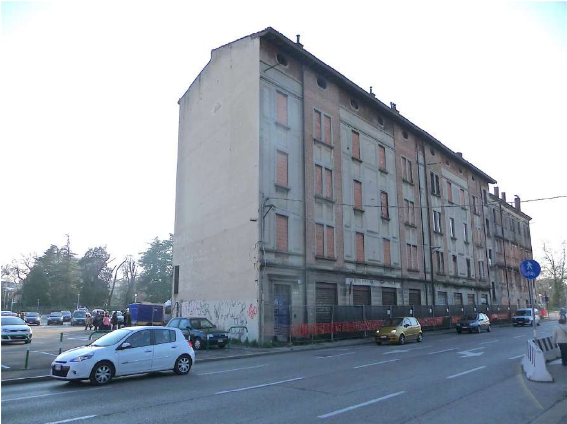
Prospetto cieco lungo palazzina Ovest
