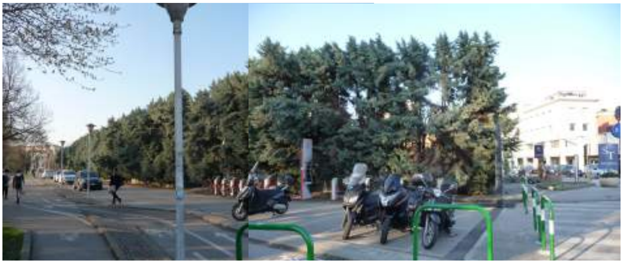
Percorso ciclopedonale che lambisce l'area di intervento (che si trova a sinistra)
