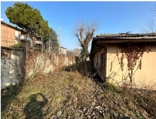
Foto 7.3 – Muro di recinzione ed edifici presenti lungo la recinzione all'interno dell'ex-caserma Romagnoli ricadenti nell'area di variante per il passaggio della linea tranviaria lungo via Michelotti (Area di Variante Comune di Padova)
