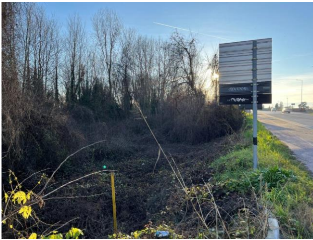
Foto 7.17 – Scarpata stradale lungo via Padova (Area di Variante del Comune di Vigonza)
