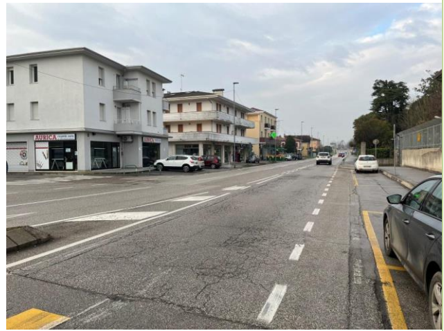
Foto 7.2 – Via San Marco a Ponte di Brenta dove sono previste piccole aree di variante lungo la viabilità esistente (Area di Variante Comune di Padova)
